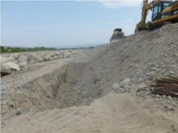
Excavación de Uña o Dentellón
