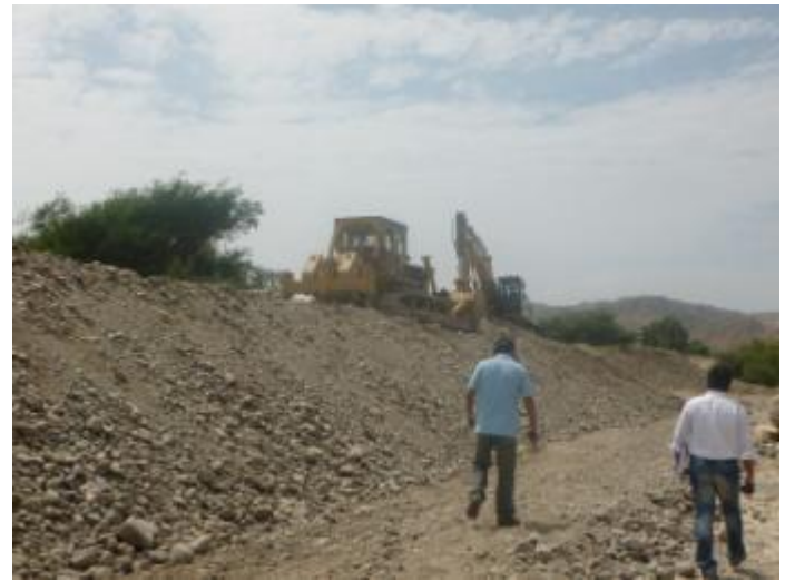
Conformación de Dique de Encauzamiento
