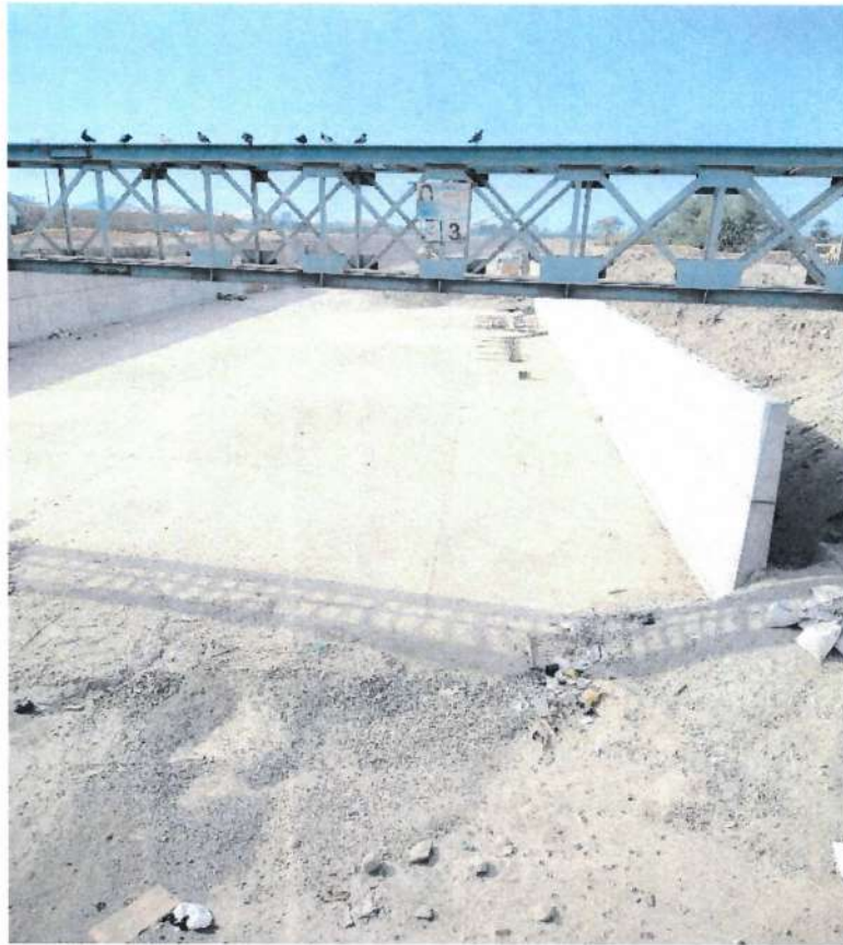
Muros de contención en tramos del río Ica.
